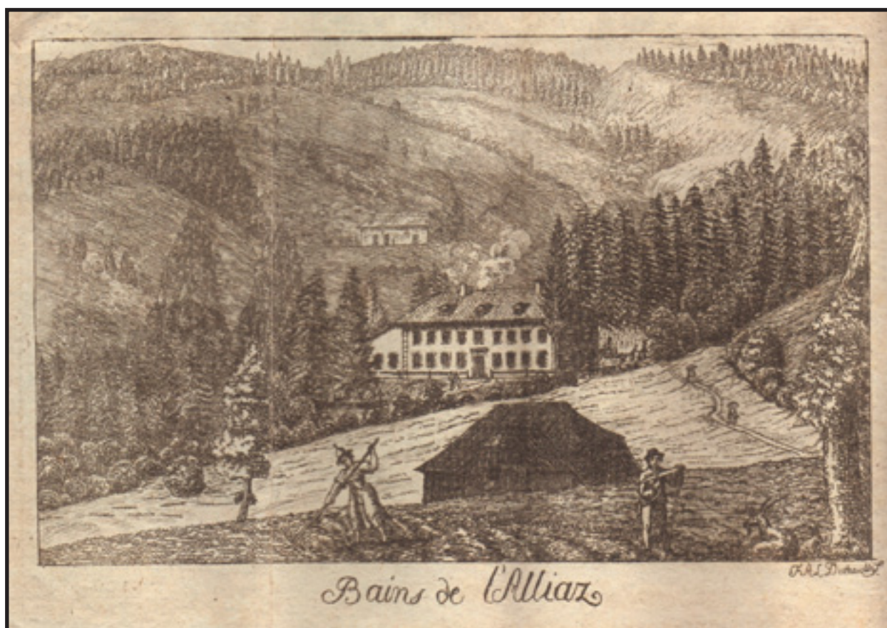
Le premier bâtiment des Bains de l'Alliaz. Gravure réalisée par François Dumoulin, publiée en frontispice des Étrennes Helvétiques et Patriotiques du Doyen Bridel en 1815. (Collection privée).
