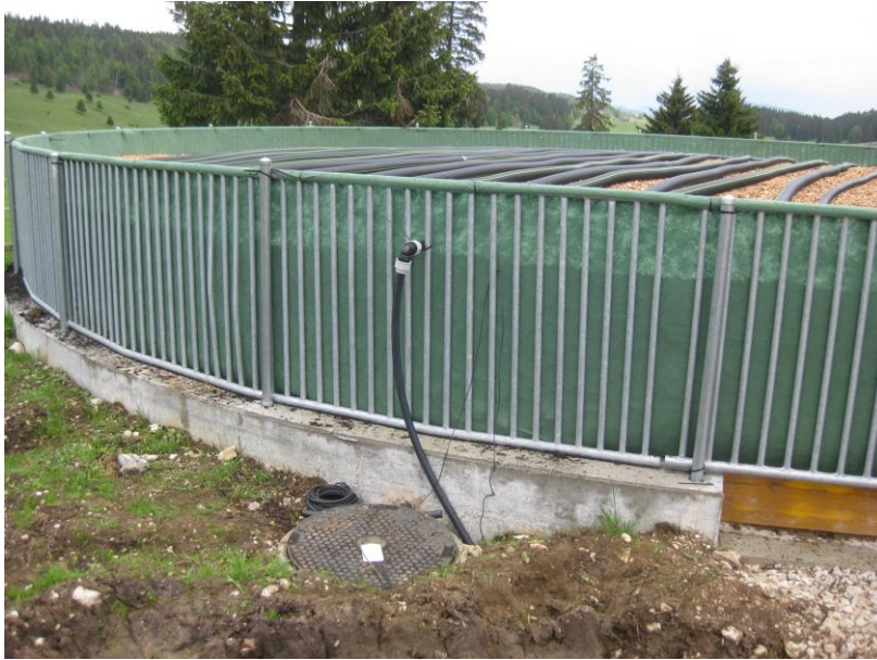
Arrivée du lactosérum dans les tuyaux de distribution
