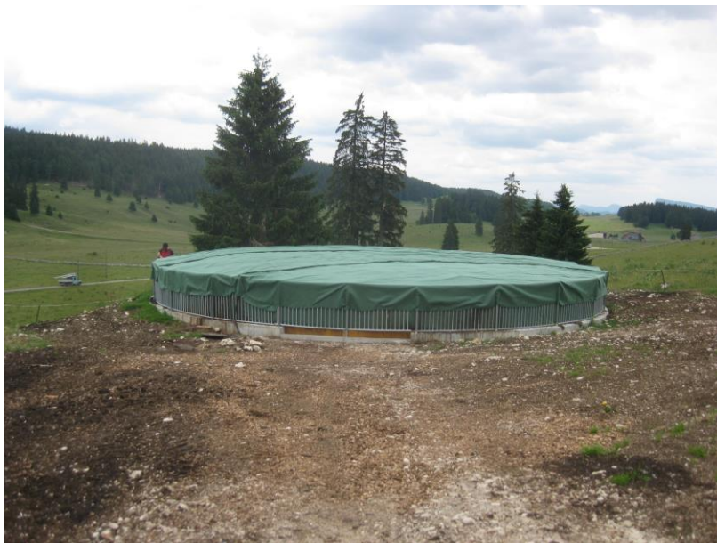
Couverture de l'installation avec un bâche de type Topex
