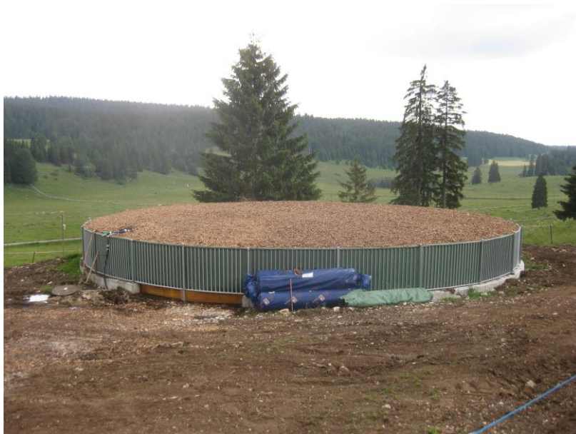
Couverture des tuyaux avec des plaquettes
